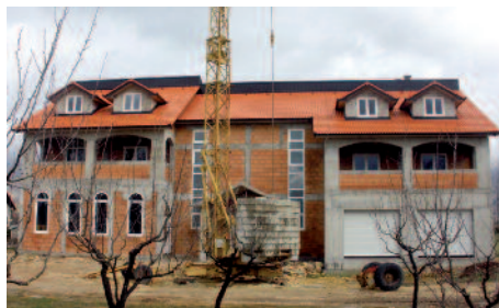
Dank Euch eine große Zukunft: Rohbau eines Diözesanzentrums in Litauen.
