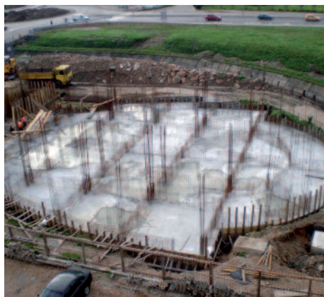
Die Fundamente sind gelegt: Auf diesem “Felsen” soll St. Peter stehen.
