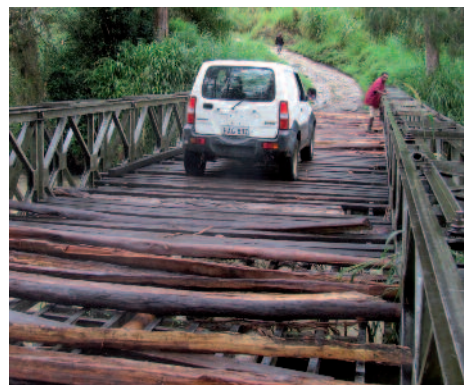
Soweit die Balken tragen: Brücke über den Fluss nach Wara-Lai.
