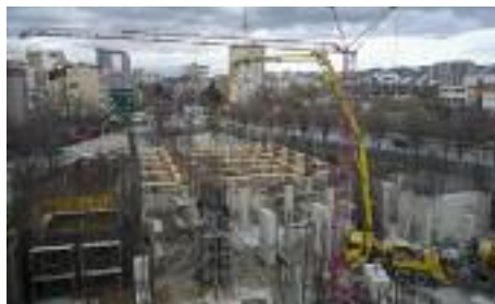
Stätte der Begegnung: Der Rohbau der Kathedrale in Pristina.
