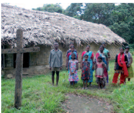
Ein dichtes Dach aus Blech soll es sein: Treffpunkt Kapelle.
