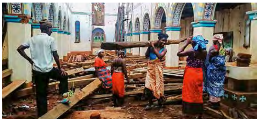
Wiederaufbau der Pfarrkirche St. Josef in Mitúcue.
